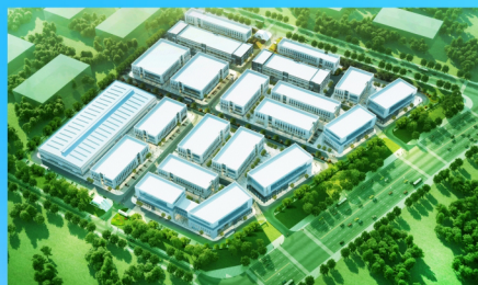
铜陵义安经开区新材料产业园EPC总承包项目
