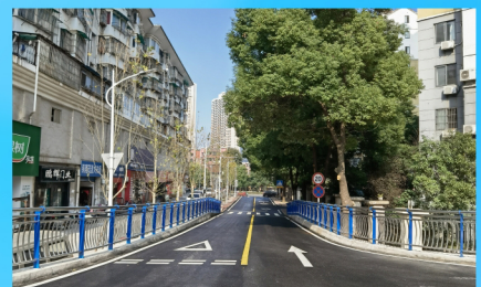
铜陵市花园新村微循环道路工程
