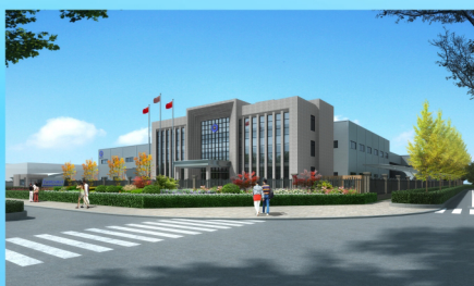
年产5万吨猫砂项目科技研发楼工程
