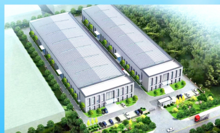
年产30万台套智能水务系统 阀门项目1#综合车间工程
