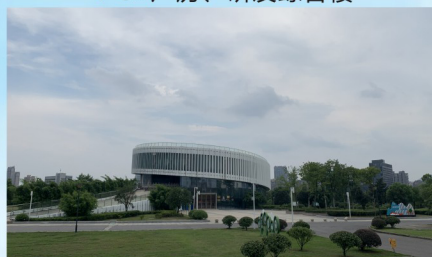
铜陵市城市展示馆室外工程
