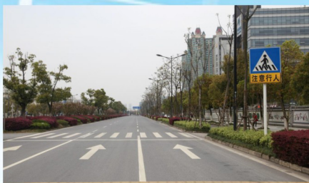
铜陵经开区2014年度市政道路维修工程
