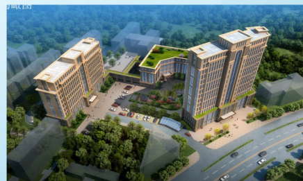
老年公寓三期工程
