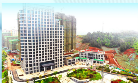
龙山湖苑·云峰居13#14#楼工程
