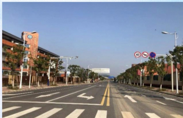
昆仑地块配建道路（立新路、新庙王路、工程竣工结算审计）
