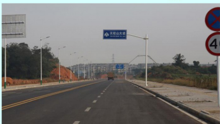
天柱山大道项目
