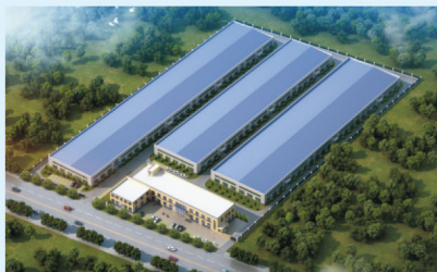
马鞍山中高温厂房项目
