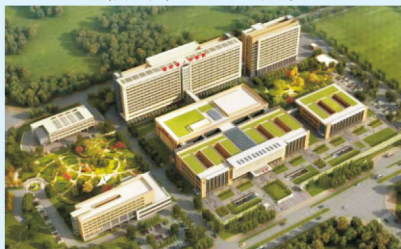
宿松人医门诊楼项目
