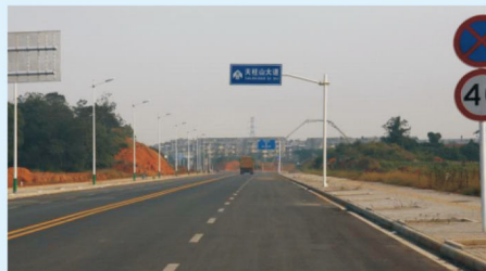
天柱山大道项目
