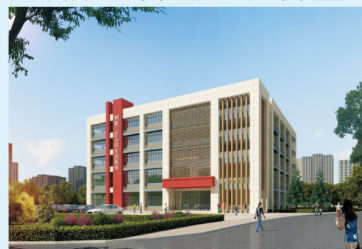
铜陵工匠实训大楼项目
