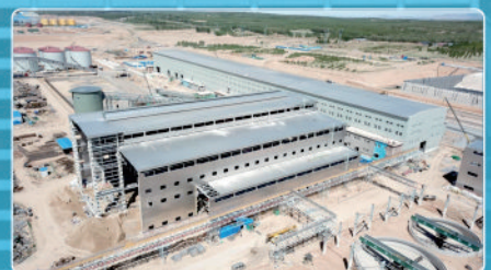
施工中的赤峰金剑铜冶炼工艺升级 搬迁改造项目工程
