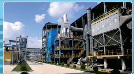
山东招金氯化焙烧车间工程
