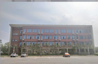
一中教学楼工程
