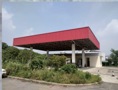
八一加油站工程
