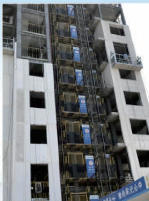
高层外墙板材安装
