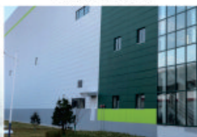
外墙板材安装完工实景效果
