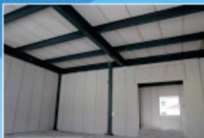
钢结构板材安装图例
