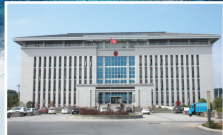
枞阳政务服务中心(市优良工程)
