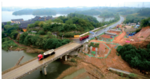
铜陵市G236青通河大桥改建工程跟踪审计项目
