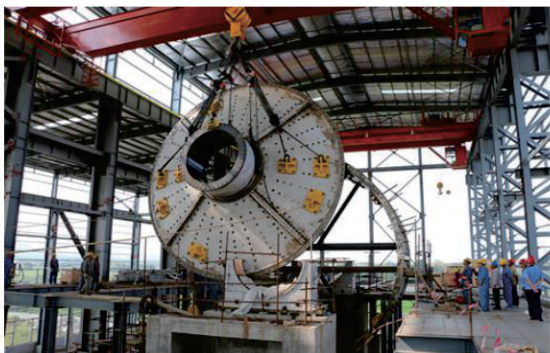
庐江矿业设备安装
