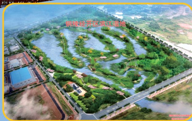
滨江生态湿地工程(湿地构建和水生态系统)招标代理
