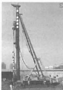
三轴搅拌机械设备高度约36.5米,宽度约15米;
