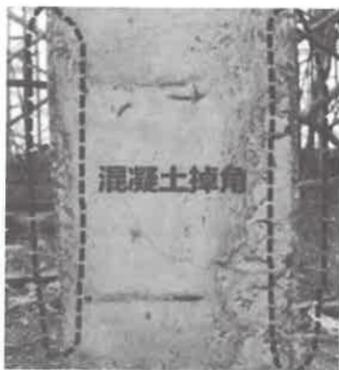
养护不好,棱角处砼的水分被模板大量吸收,致使砼水化不好,强度降低,拆模时棱角被粘掉;
