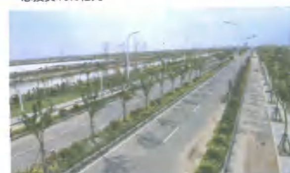
■ 新滩产业区启动区一期基础工程全过程跟踪审计、结算审计 总投资5亿元
