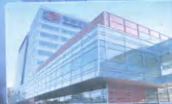
▲ 北京安泰制药有限公司研发中心扩建项目 项目概况：总建筑面积100000平方米，总投资1000000000元
