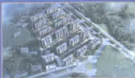
镇江中南上悦诗苑全过程跟踪审计项目 建筑规模: 总建筑面积13万平方米, 投资总额5.6亿元
