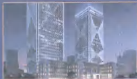
道成科技大厦全过程跟踪审计项目 建筑规模: 总建筑面积11万平方米, 总投资约8亿元
