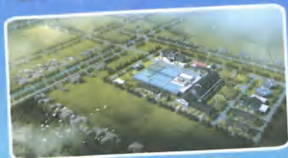
◆盐城新水源地建设及引水工程一标段 跟踪审计 工程总投资65亿元
