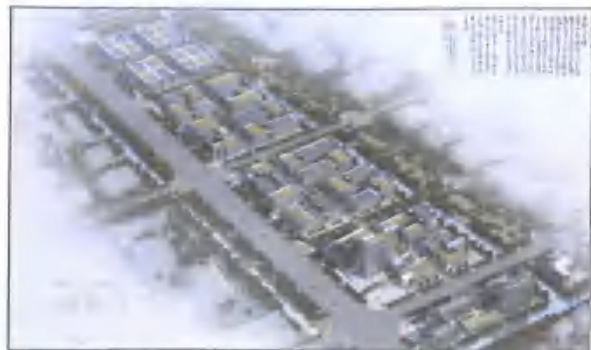
■ 盐城市新洋经济区科技孵化区 12#-21# 厂房全过程跟踪审计, 总建筑面积为 108740 平方米, 总投资约 2.5 亿元。
