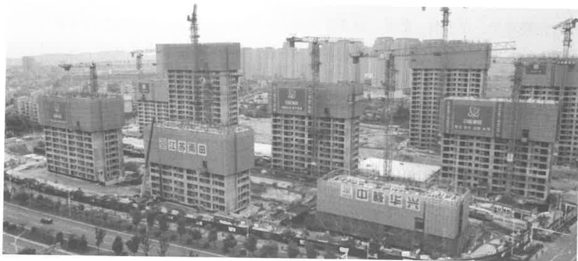
图3 装配式建筑铝膜爬架一体化施工
